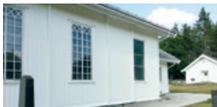
Slik er sydsiden av kirka blitt. Det gjenstår å restaurere vinduene, men det regner vi med blir gjort i løpet av høsten.
