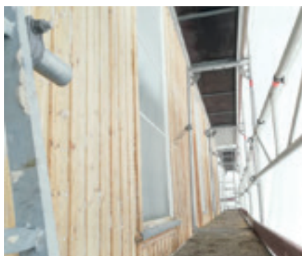
Utvendig ble veggene sandblåst. Dette er en effektiv måte å få bort gammel maling. Samtidig river sanden opp treverket, og det blir veldig ruglete.
